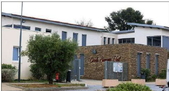
Une extension de l'école Simone-Veil est prévue avec la création d'une classe de maternelle, ce qui portera à neuf le nombre de classes du groupe scolaire sur le site de La Castellane. (Photo Frank Muller)
