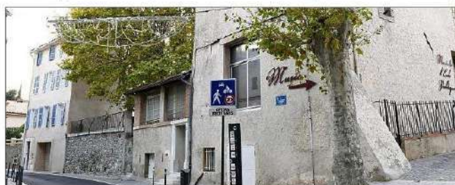
Rue Anatole-France, l'ancienne école Sainte-Geneviève, qui abrite le musée de l'école publique, va être réhabilitée en 2022.
