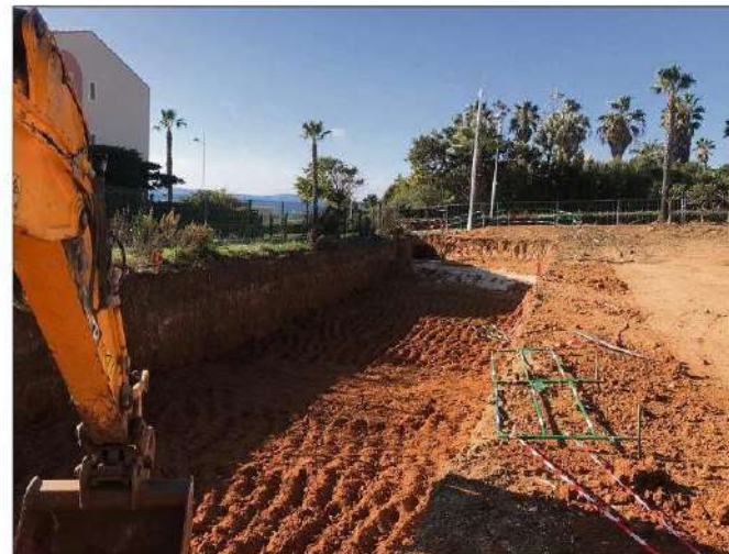
Édifié sur un ancien terrain vague, l'aménagement qui se veut paysager sera doté d'un bassin de rétention d'une capacité de 290 m 3 .
