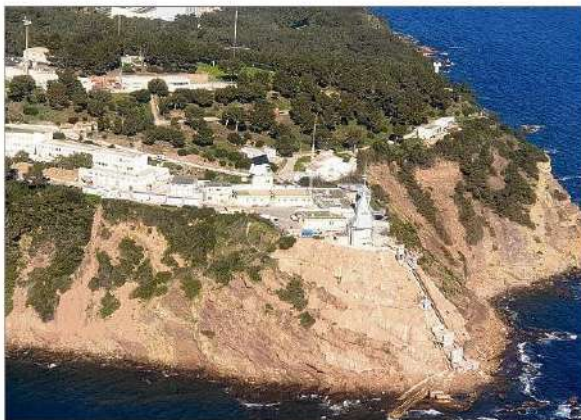
Surplombant le cap Cépet, ouvert sur la mer à 270°, le Sesda change de physionomie au gré des navires en développement. (Photos DR/DGA)
