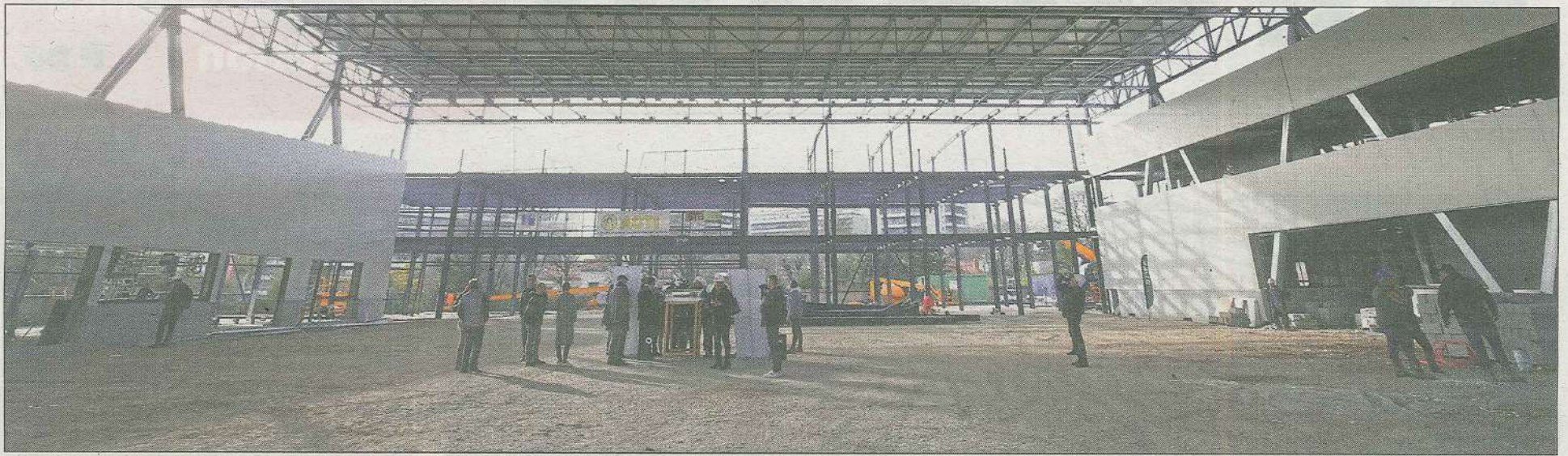
Depuis le centre de la pelouse synthétique, on peut voir les différents bâtiments en construction : à gauche, le centre de formation ; au centre, l'espace restauration au rez-de-chaussée et des bureaux à l'étage ; à droite en rez-de-chaussée, l'espace des pros (vestiaire, salle de musculation, espace balnéothérapie), à l'étage, bureaux du staff technique et espace de vie des joueurs avec terrasse.
