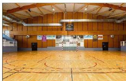
La salle omnisports Maurice-Baquet a eu droit un sacré lifting : deux millions d'euros de travaux. (Photo doc. S. T.)
