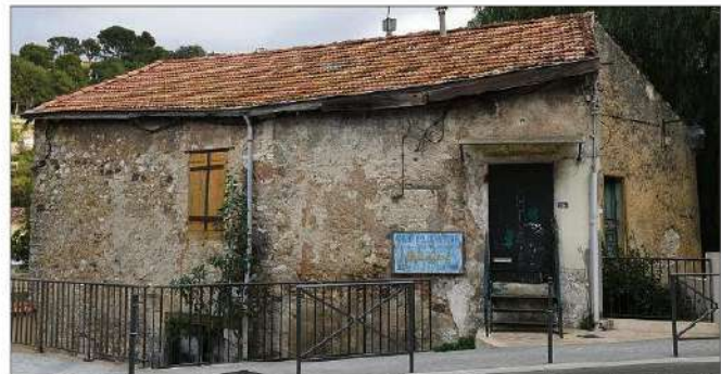
La vieille bâtisse, en bordure de la Reppe, à l'entrée des Gorges va être réhabilitée pour y abriter au plus tard en 2022 le futur musée des Clés et de la Serrure.
