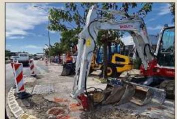
Les travaux ont débuté début octobre et finiront début décembre. La plupart des travaux seront réalisés de nuit. (Photo C. V.)
