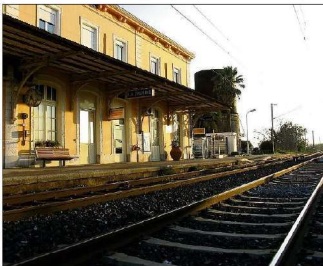
La gare de La Pauline est au centre du projet Ligne nouvelle. (Photo doc. V.-m.)
