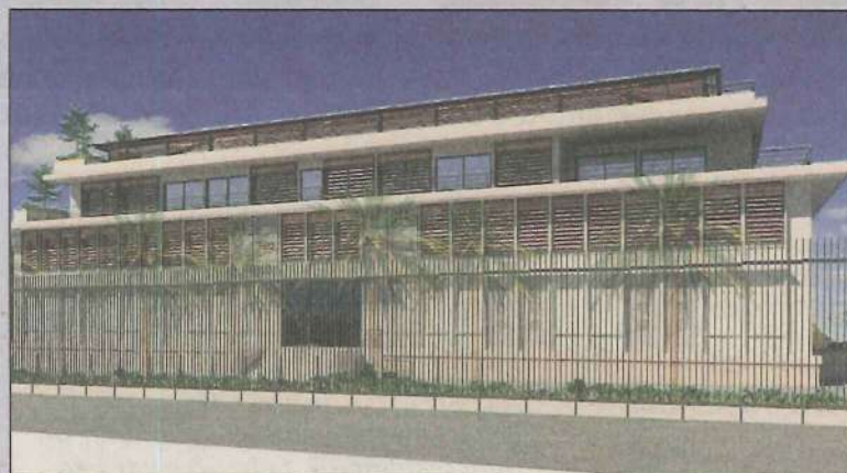
Un data center et des espaces dédiés aux startups de la région sont prévus ici. (Photo-repro DR)
