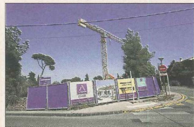
D'abord arrêté, le chantier a fait marche arrière
