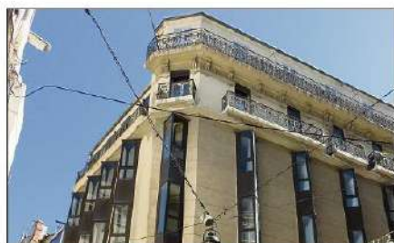
Les oriels et des éléments de façade en aluminium actuels vont être enlevés. (Photo DR)
