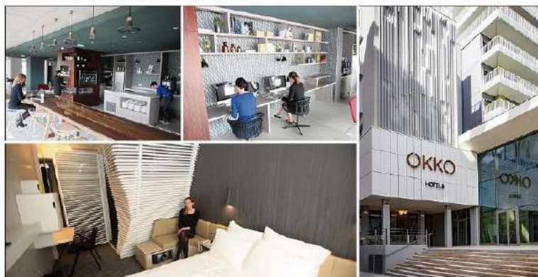
Après Cannes en 2016 (photos ci-dessus), le nouvel Okko Hôtel de Toulon, dixième du nom et quatre étoiles (à droite), a ouvert ses portes quelques jours avant le confinement avant de rouvrir le 2 juin. Il est situé lui aussi près de la gare, place de la Liberté. (Photos D.R. et doc. V.-M.)
