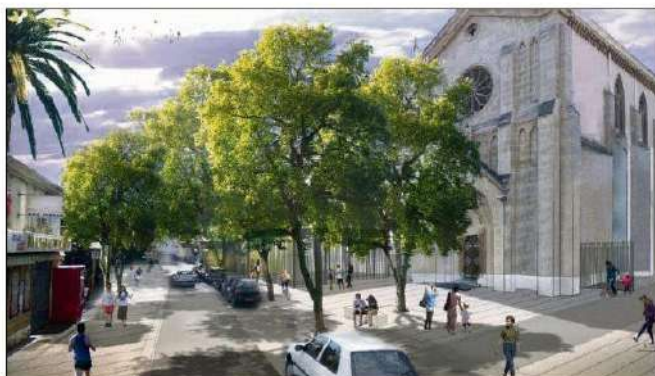
Voici, ci-dessus, à quoi devrait ressembler la place Germain-Loro, avec son ouverture sur la chapelle des Maristes, quand s'achèveront les travaux l'an prochain. A droite, la maire Nathalie Bicaïs venue constater l'avancée du chantier.
