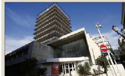
La tour en 2017, au début des travaux de transformation. (Photo Patrick Blanchard)
